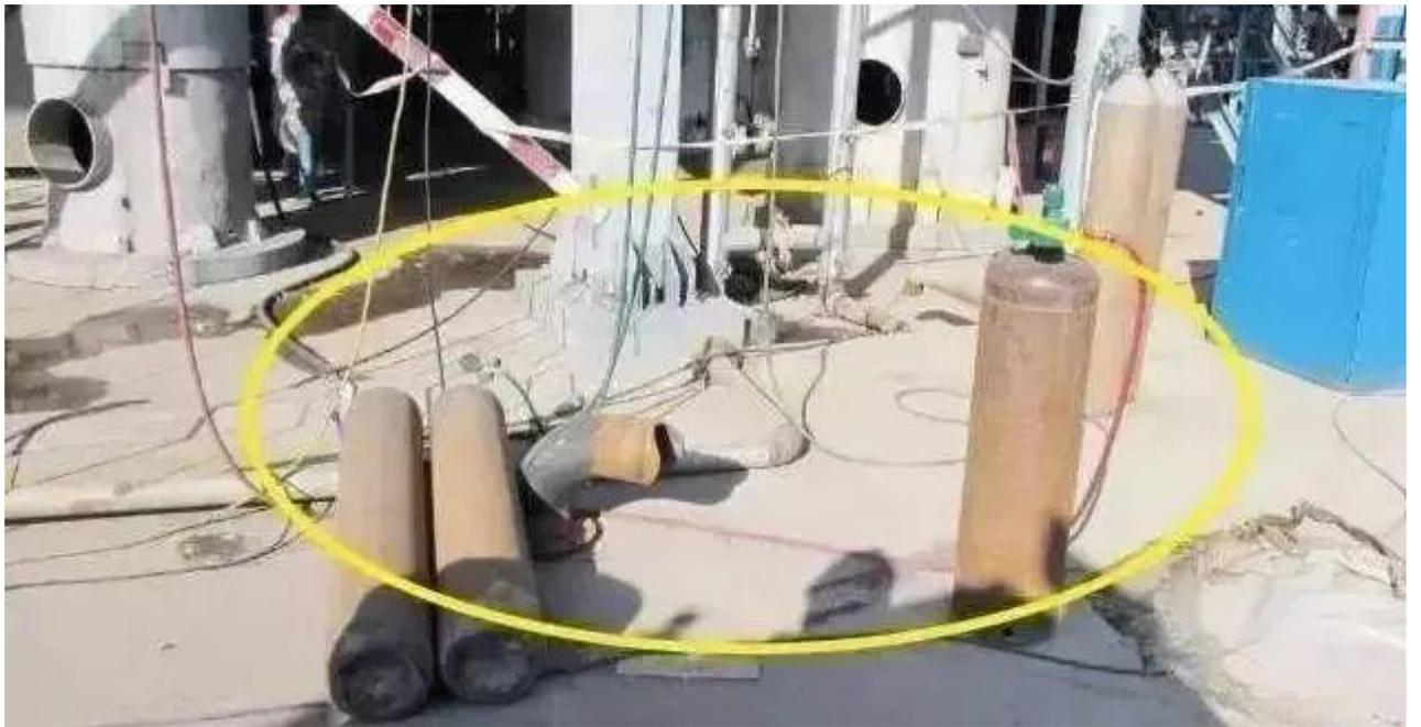
▲气瓶无防护圈，瓶间距应小于 5 米，无防倒设置，气线颜色混乱。
