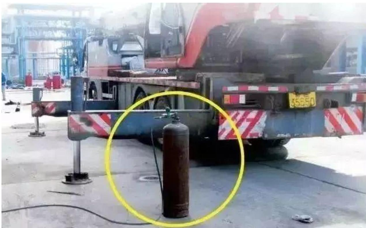
▲气瓶在吊车作业范围内，无防护圈，无防倒设置。
