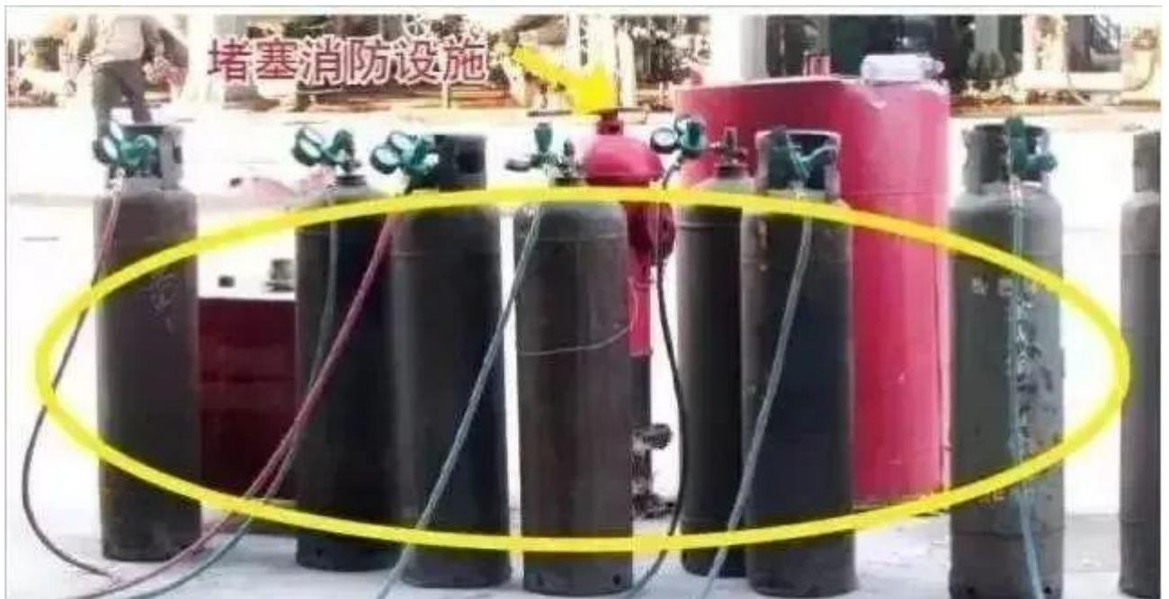
▲气线应为红色，施工现场同类气瓶数量不得超过 5 支，无防护圈，无防倒设置，安全附件不全。
